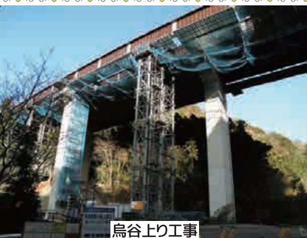
烏谷上り工事
