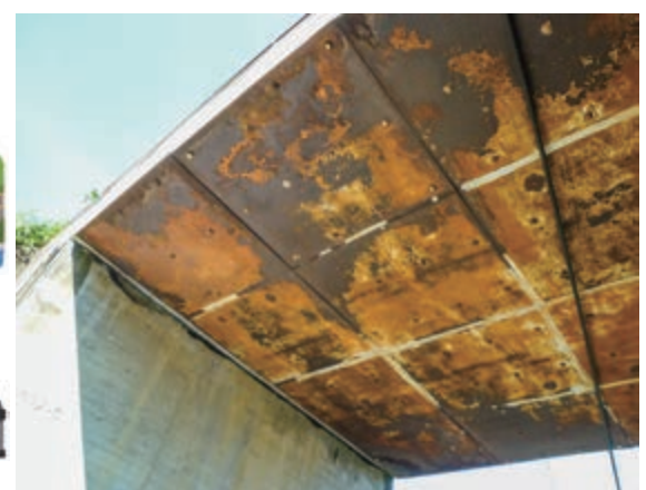
架道橋の裏側
